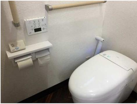
トイレの2度流しをしないために擬音装置を設置
